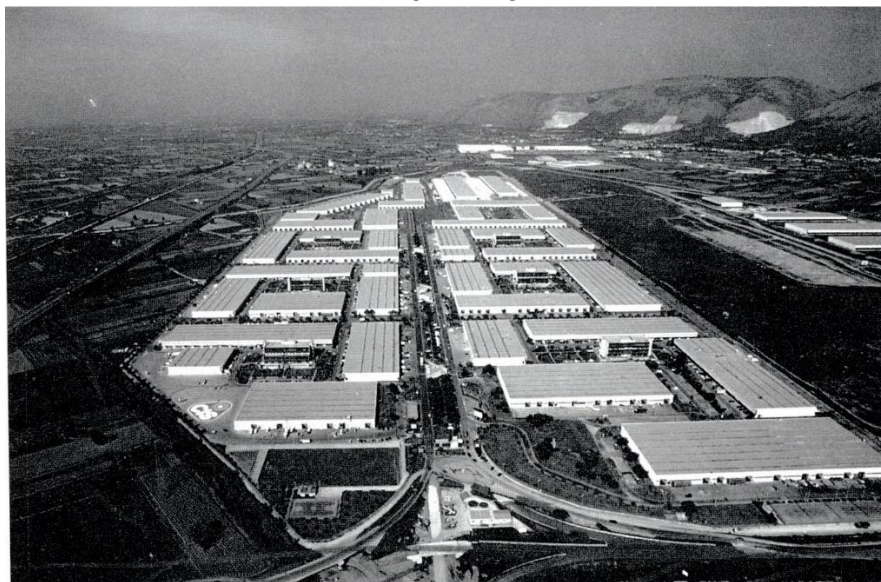
FIG 12 Paesaggio industriale e commerciale del Centro Ingresso Sud – Interporto di Nola (da Fusco).
